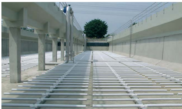
Detalle del sistema de instalación de parrillas fijas AIRREX elegido
