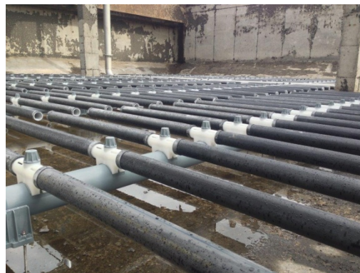
Detalle del sistema de instalación de parrillas fijas AIRREX elegido
