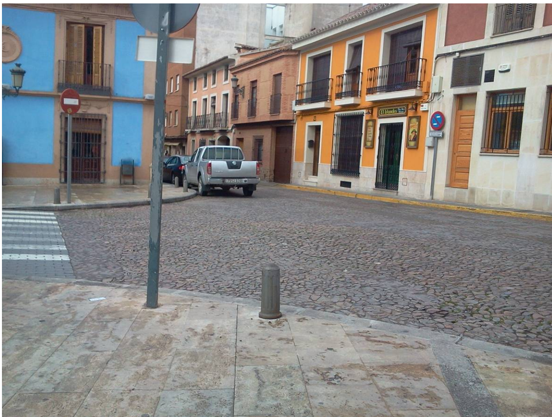
Foto 3.- Acera no accesible. Falta de paso de peatones regulado
