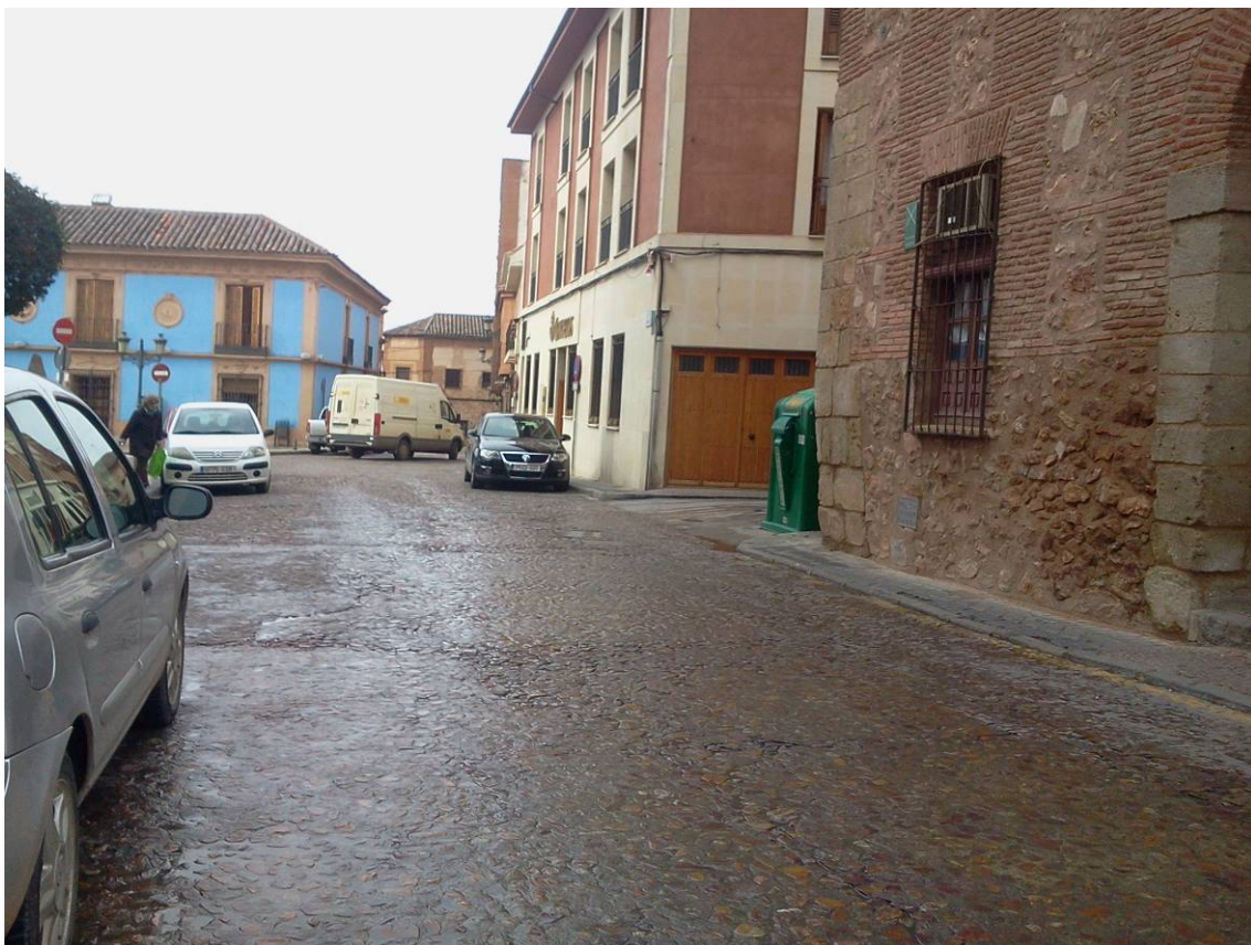
Foto 1.- Acera no accesible. Falta de paso de peatones regulado
