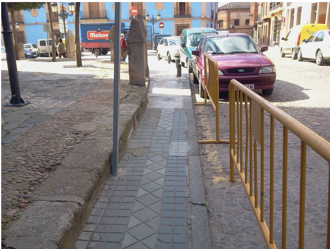
Foto 2.- Acera no accesible. Falta de paso de peatones regulado
