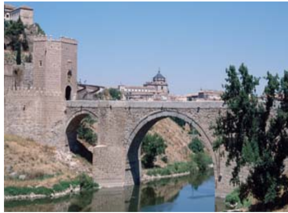
Puente de Alcántara, Toledo. Fuente: Cnice
