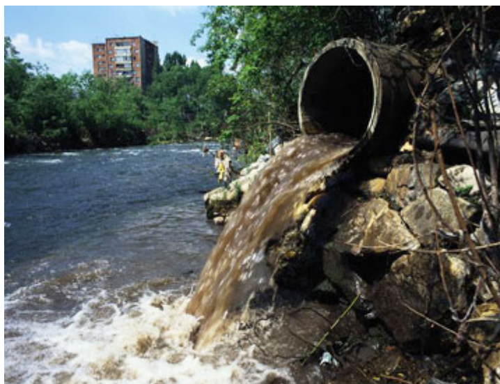
Vertido de aguas sin depurar a un cauce fluvial
